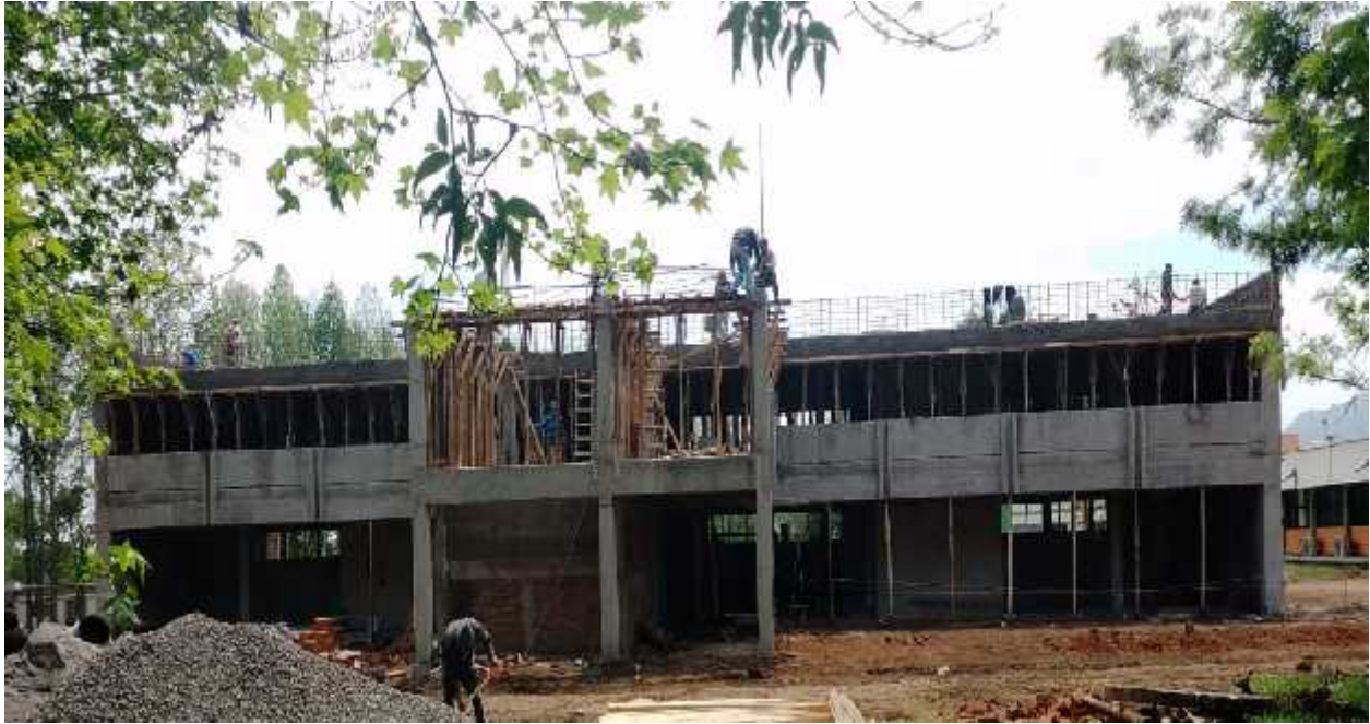
Figura. Construcción de un Edificio tipo H 1ra. Etapa
