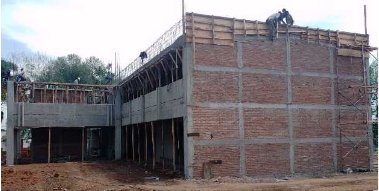
Figura. Construcción de un Edificio tipo H 1ra. Etapa
